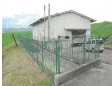
調整池周辺フェンス設置
