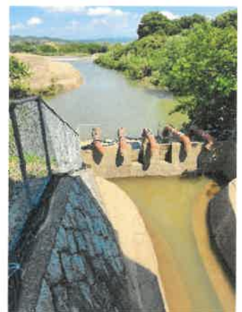
木津川導水路浚渫工事
