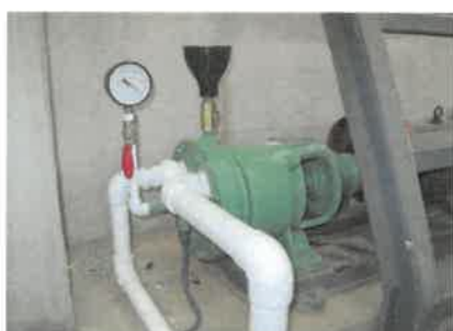
真空ポンプ更新
