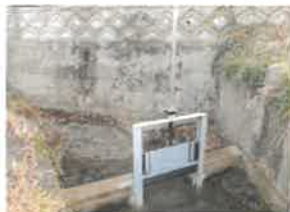
水路ゲート(堰)補修工事(植田)
