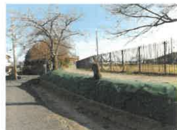
蓮池堤体防草シート張工事(植田)
