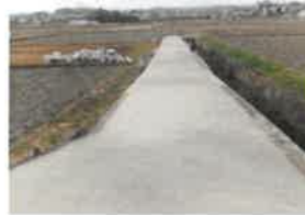
農道アスファルト補修工事(菅井)
