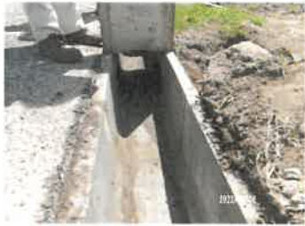
水路補修工事(南)一目地・マス補修
