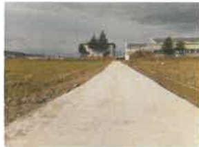
農道更新工事(中)未舗装農道のコンクリート舗装
