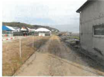
農道補修工事(谷)一鋤取り
